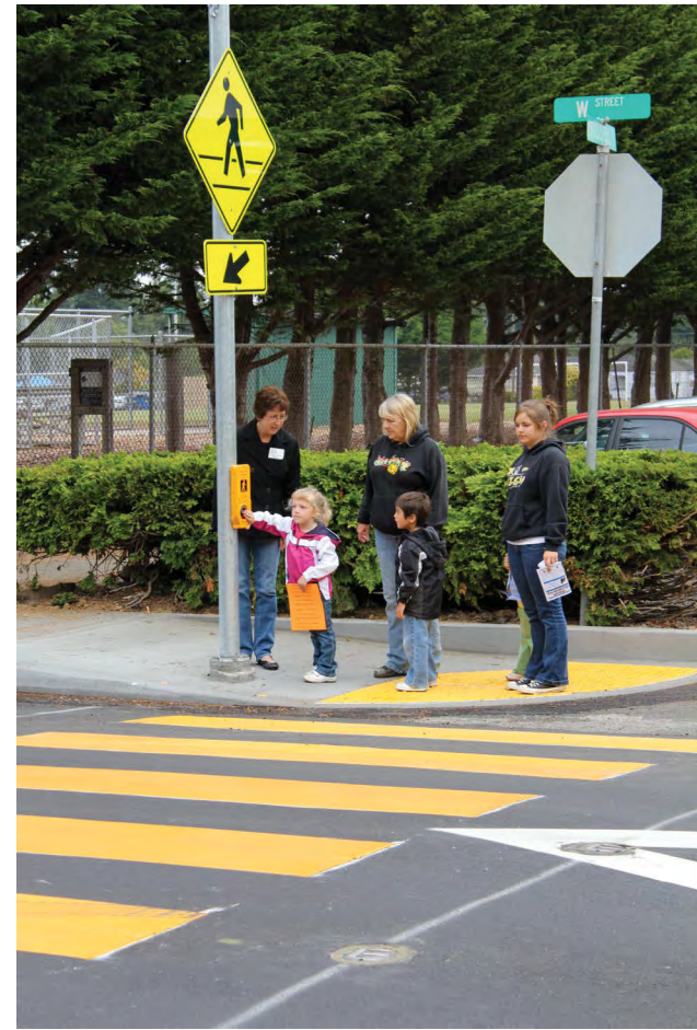
Pedestrian Activated Light Semáforo Activado por Peatones
